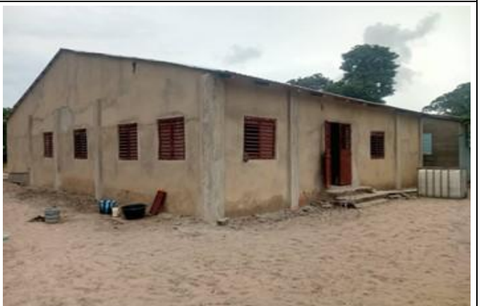
Réfection en cours du poste de santé de Djinack Bara.
